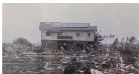
(東日本大震災の大津波に耐えた住宅 )
