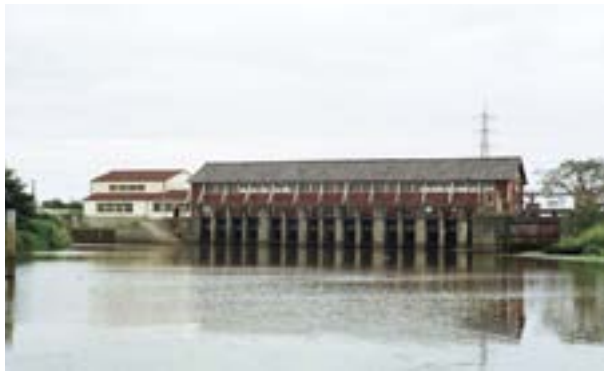
栗ノ木排水機場
