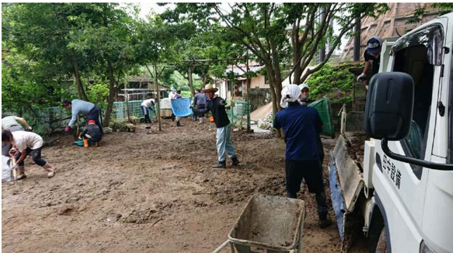
もぐし保育園庭内に 入り込んだ土砂出し作業
