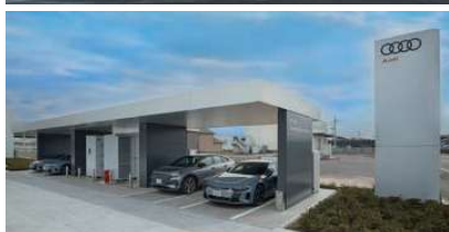
電気自動車の急速充電サービスを提供する「Audi charging station 厚木」
