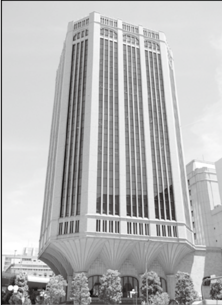
大同生命大阪本社ビル(大阪市西区江戸堀) ～加島屋が店を構えた地に建つ～
