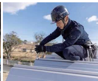
外装部分を美しく施工
