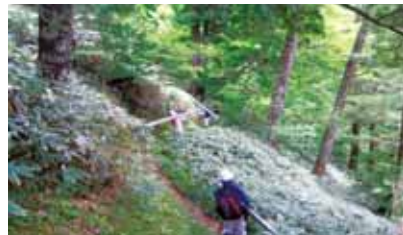
鋼製足場板を担いで2時間の登山です
