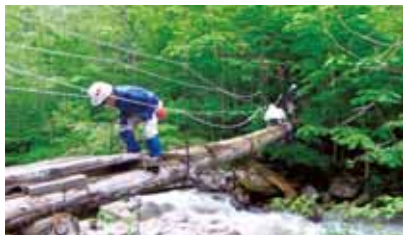
空木山登山道吊橋修繕作業状況
