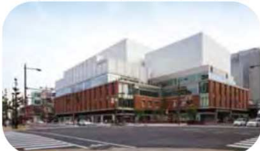
実績例：久留米シティプラザ（設計・監理チーム）
