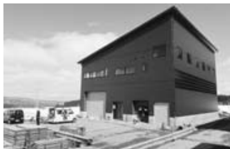
建設中のスタジオ付きの新工場
