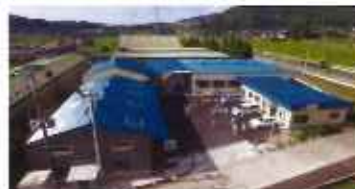
本社社屋・工場
