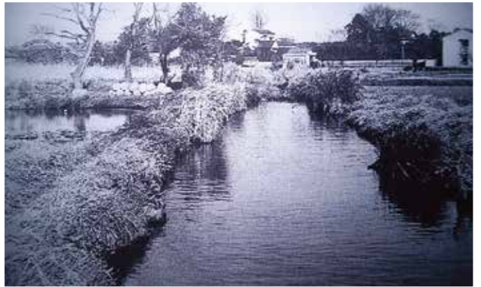
◆合流工事前の鴻沼排水路(昭和三十八年)
